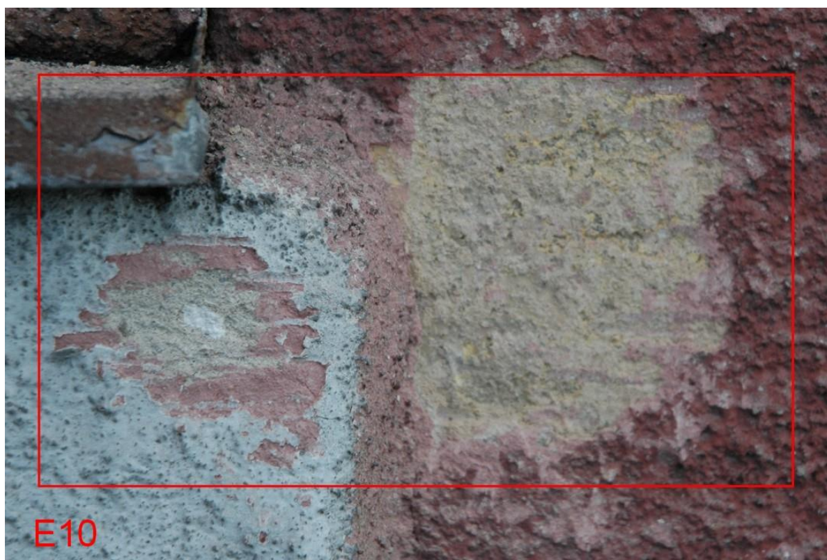
Odkrywka E10. Widoczne ugrowe wymalowanie ścian wg NCS-u S 1020-Y20R.
