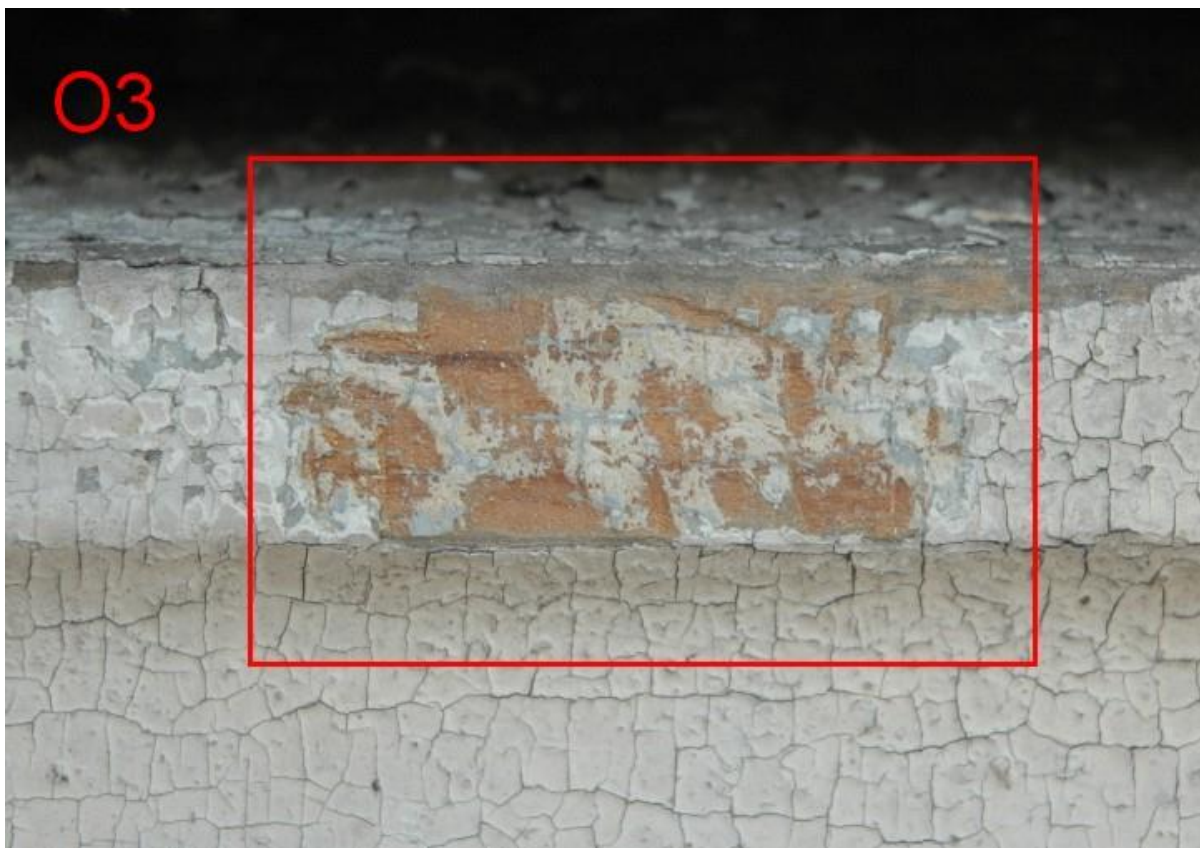
Odkrywka O3. Widoczne wymalowanie w kolorze ecru wg NCS-u S 1005-Y30R.
