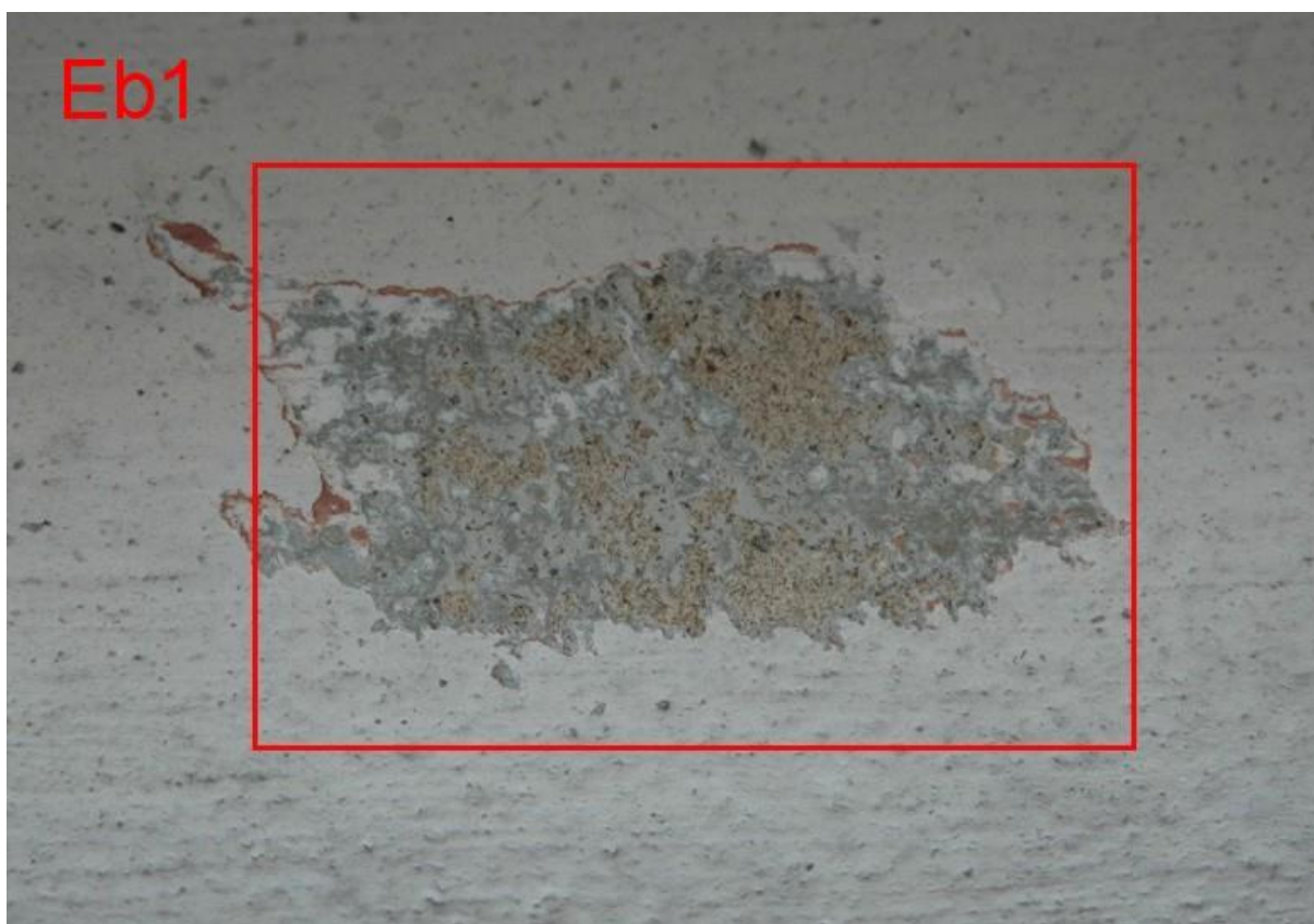
Odkrywka Eb1. Widoczne szare wymalowanie gzymsu wg NCS-u S 1502-B.
