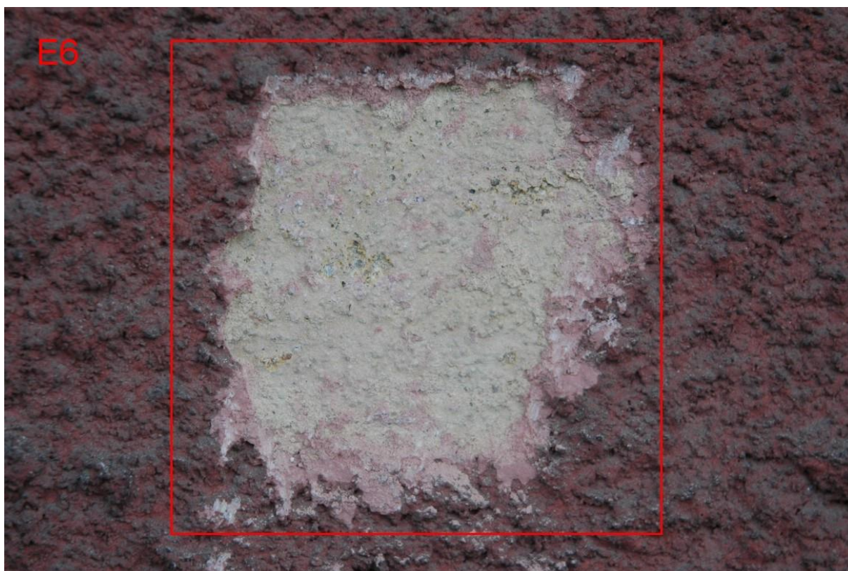
Odkrywka E6. Widoczne ugrowe wymalowanie ścian wg NCS-u S 1020-Y20R.
