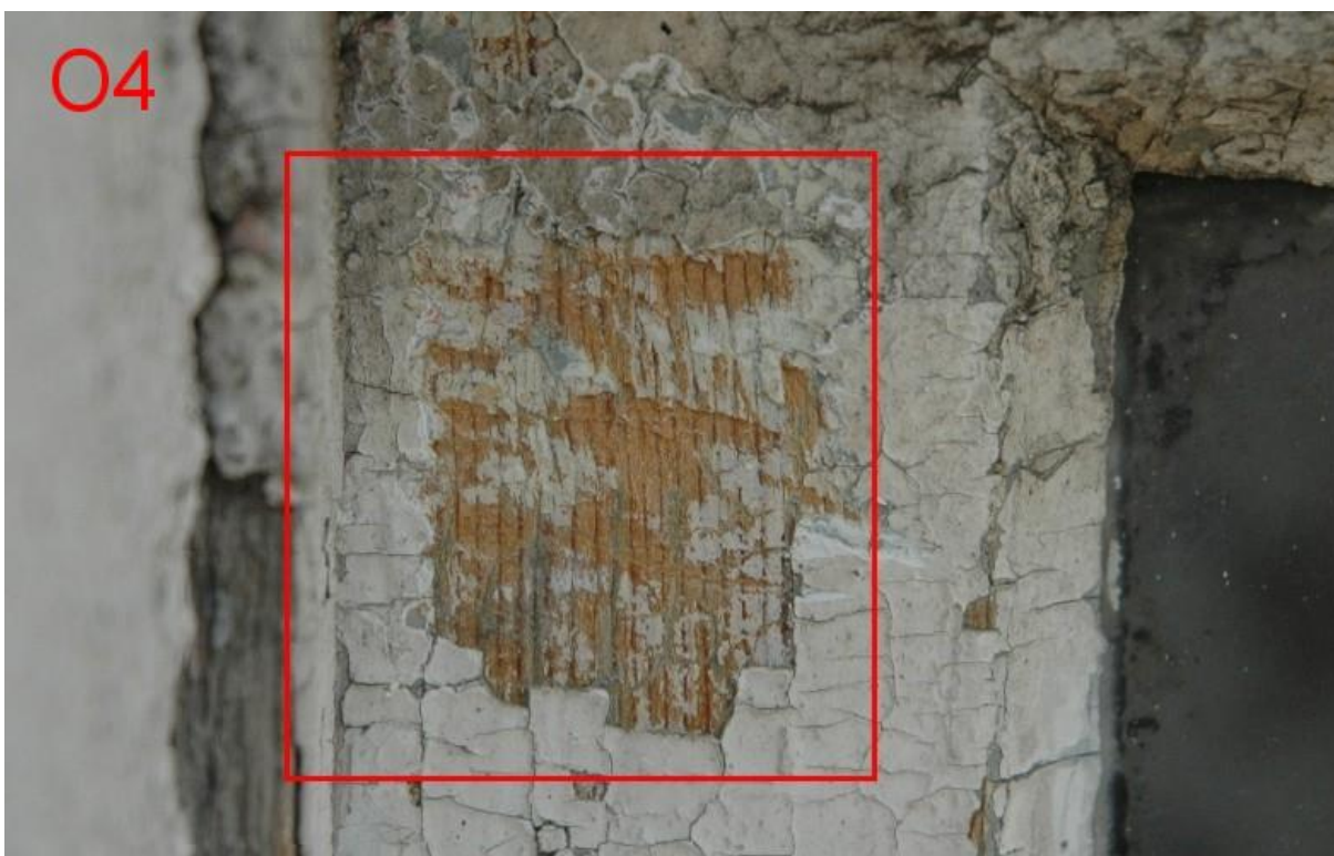
Odkrywka O4. Widoczne wymalowanie w kolorze ecru wg NCS-u S 1005-Y30R.
