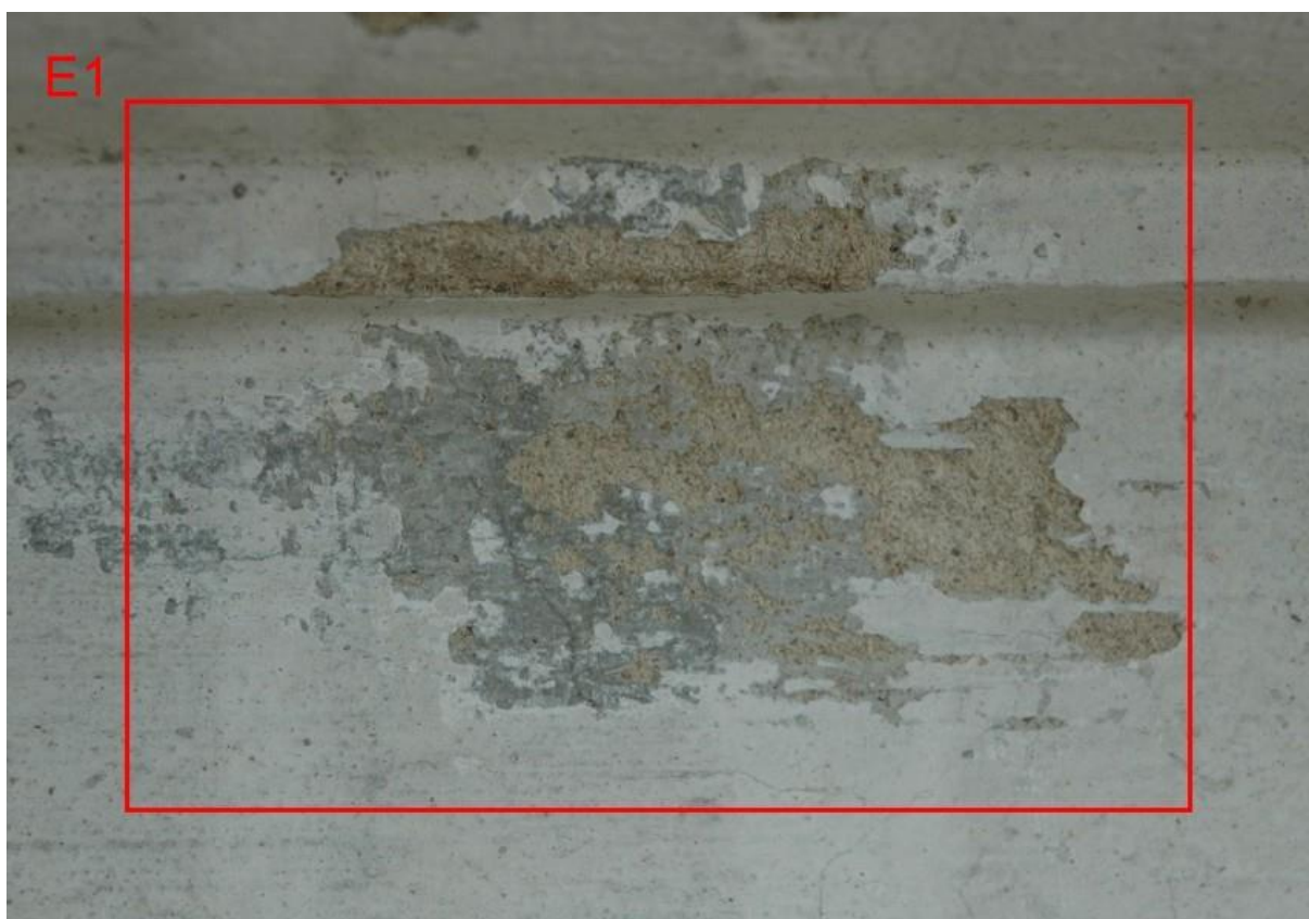
Odkrywka E1. Widoczne szare wymalowanie gzymsu wg NCS-u S 1502-B.
